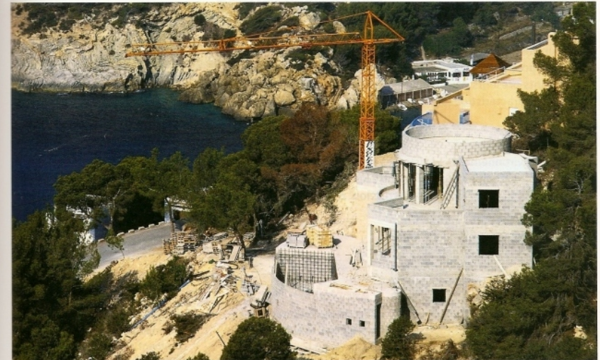
f Construction d'une maison individuelle sur le littoral.
